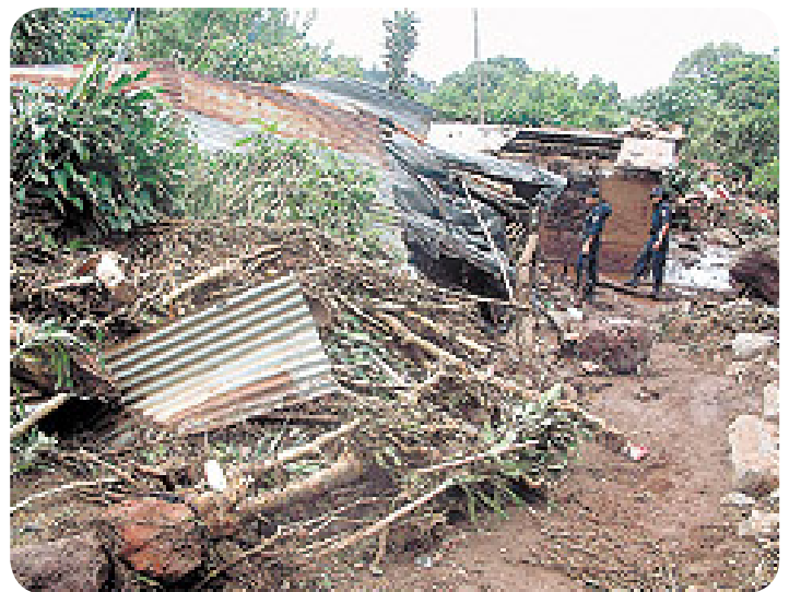
Afectados. Unas 75 viviendas fueron destruidas por los aludes de lodo que cayeron.
